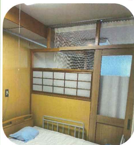
↑居室の新設間仕切り。プライバシーに配慮して。
