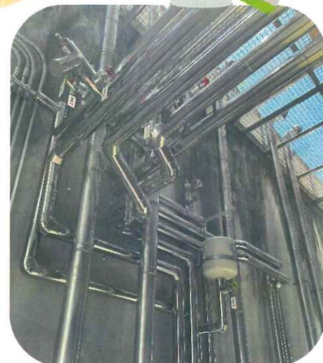
見えない部分もしっかりと改修。
